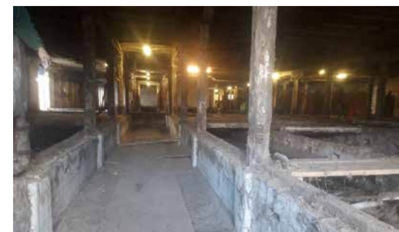
Stallet under rivningsprocessen.
