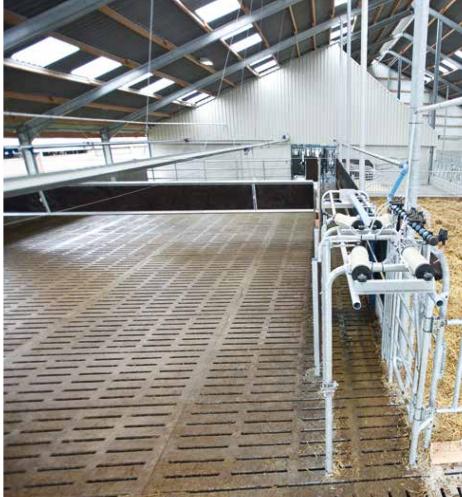
Die richtige Planung – großzügiger Vorwarte Hof und kompaktes Design des gesamten Melkzentrums.
