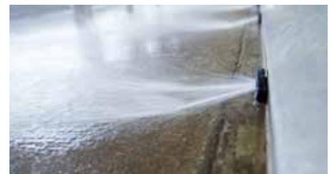
Sprühdüsen für die Reinigung der Standfläche (Deckflush)
