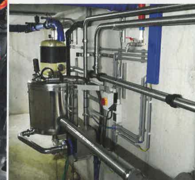
Het leidingwerk van de melkstal is weggewerkt in de kelder. Daardoor is de melkstal eenvoudig schoon te maken en is het er ook relatief stil.
