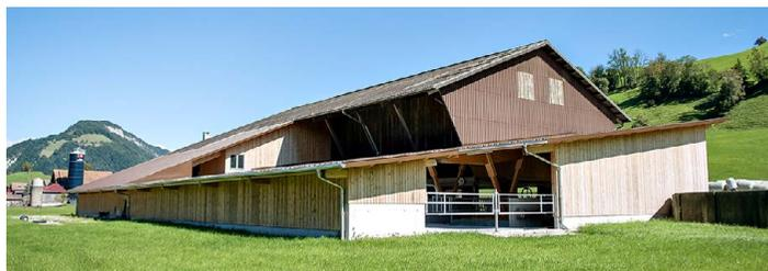
Der Anbau fügt sich harmonisch und kompakt in die bestehende Struktur ein. Unter dem Laufhof entstand eine neue Jauchegrube mit knapp 1000 m<sup>3</sup> Fassungsvermögen, die bequem mit dem Entmistungsroboter RS450 gereinigt wird.
