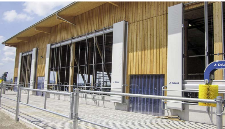
Revêtement de façade combinant bois de mélèze et système de portes à enroulement coupe-vent C78.
