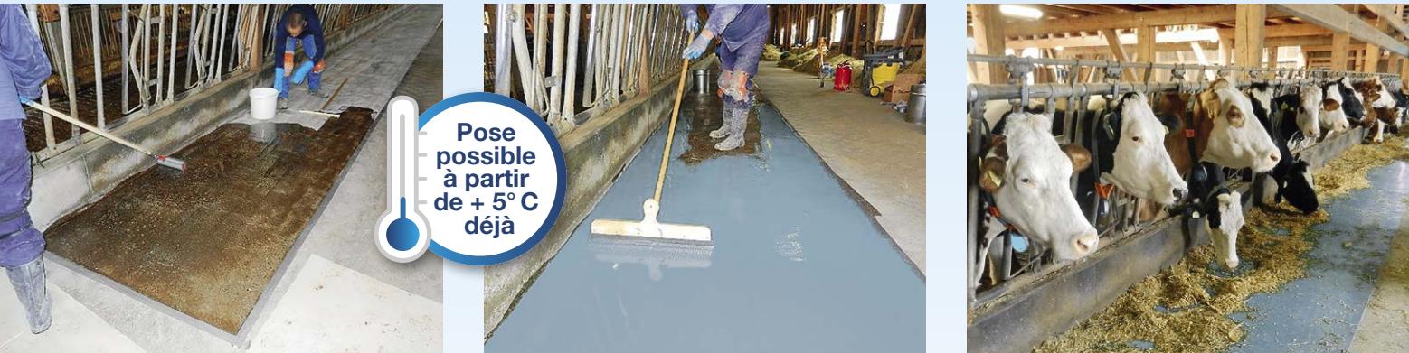
Nettoyer et fraiser le béton, puis étendre la couche de fond
