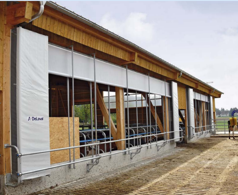
Système A: ouverture de bas en haut
