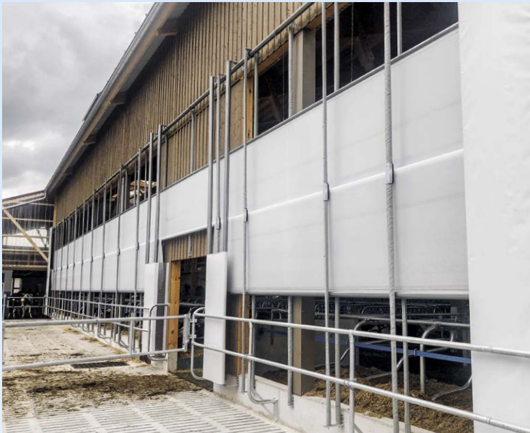
Système C: ouverture de bas en haut et de haut en bas
