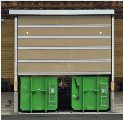
Porte d'un dépôt d'engins communal
