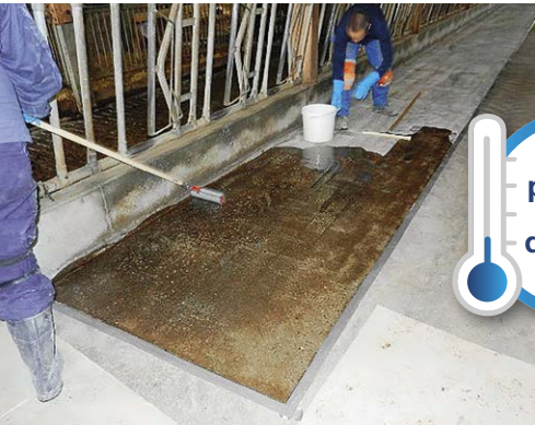
Nettoyer et fraiser le béton, puis étendre la couche de fond
