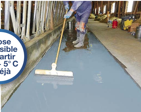
Étendre une couche de sable de quartz (3 kg/m²) puis appliquer la vitrification
