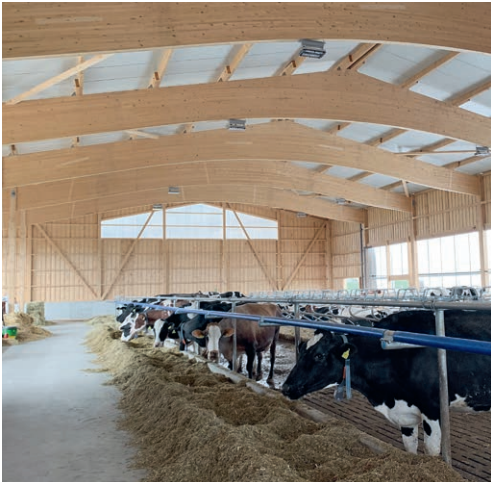
Die stützenfreie Hallenkonstruktion garantiert absolut hindernisfreie Stallabläufe.
