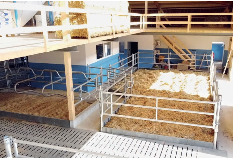
Ein wichtiger Bereich im neuen Stall ist auch der Separations- und Abkalbbereich, wo Kühe mit spezieller Aufmerksamkeit genügend Platz und Ruhe vorfinden.
