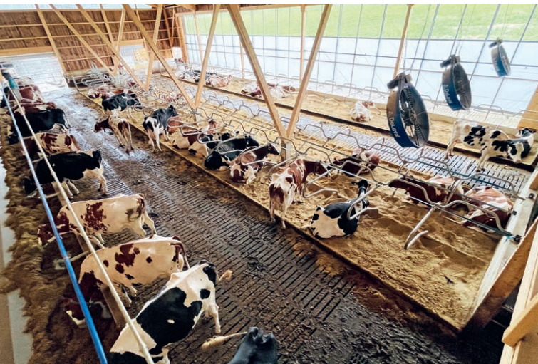
Blick in den neuen luftigen Stall mit Ventilatoren und Liegeboxen, die für gesamthaft 80 Kühe Platz bieten.
