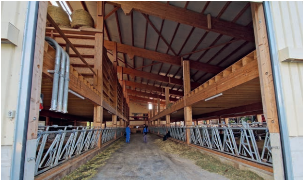
Familie Richoz profitierte vom Gesamtangebot: Die Melktechnik sowie zwei Futterstationen, das Herdenmanagementprogramm und die gesamte Stalleinrichtung inkl. Liegeboxen, Fressgitter und Bodenbeschichtungen (Plast) wurden von DeLaval geliefert.
